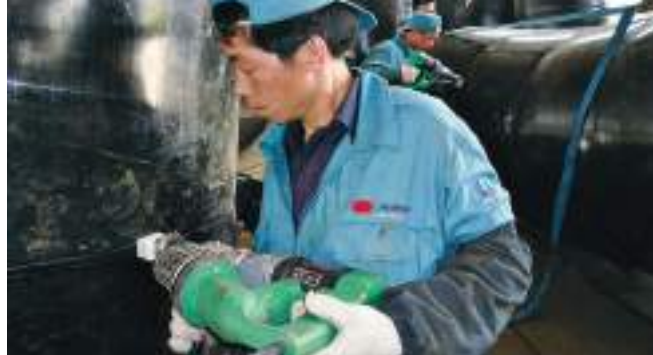
Экструдер FUSION 2 при сварке резервуара
